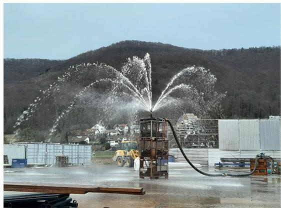
Aus der Bohrung "Urach 4" wurde 55 Grad heißes Wasser gefördert.
